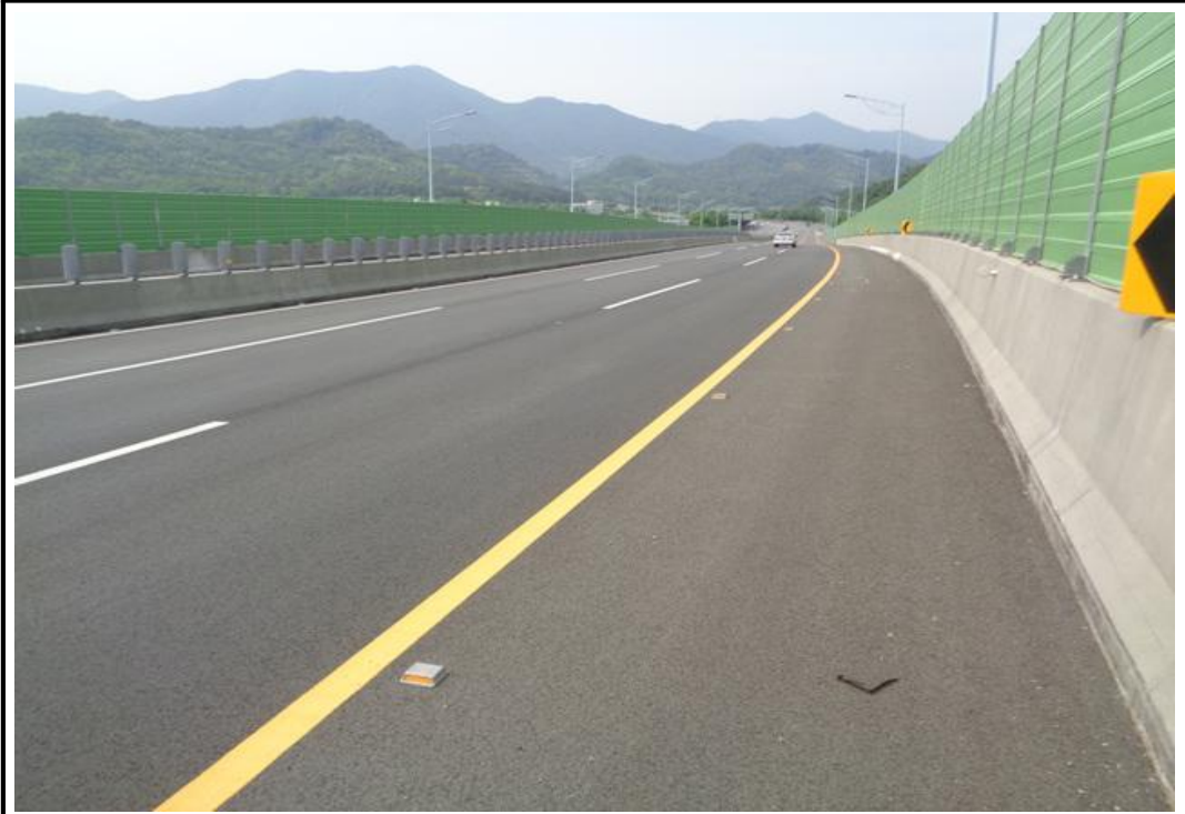
방호벽 및 중분대 전경
